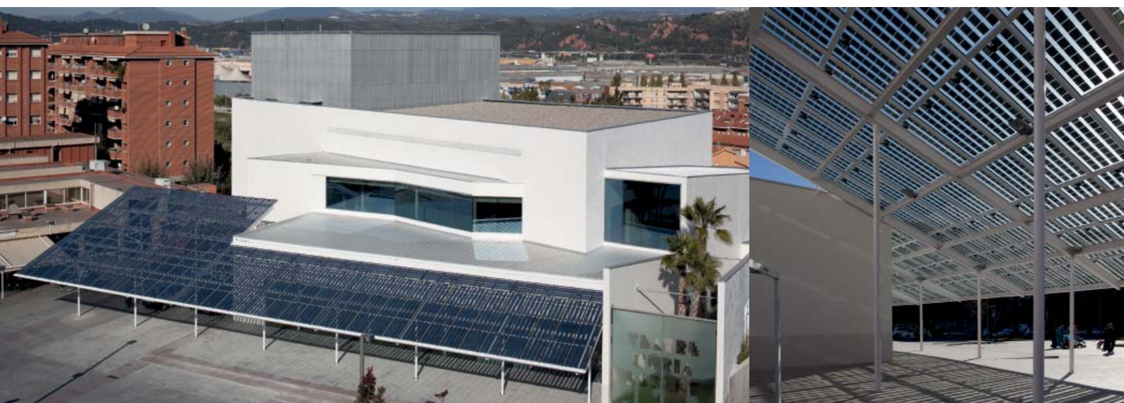
Fassadendach-Anwendung mit Photovoltaik Paneelen - Teatro Municipal Nuria Espert - Sant Andreu de la Barca, Spain (Architekt : EPG Estudios y Proyectos Grau SL)
