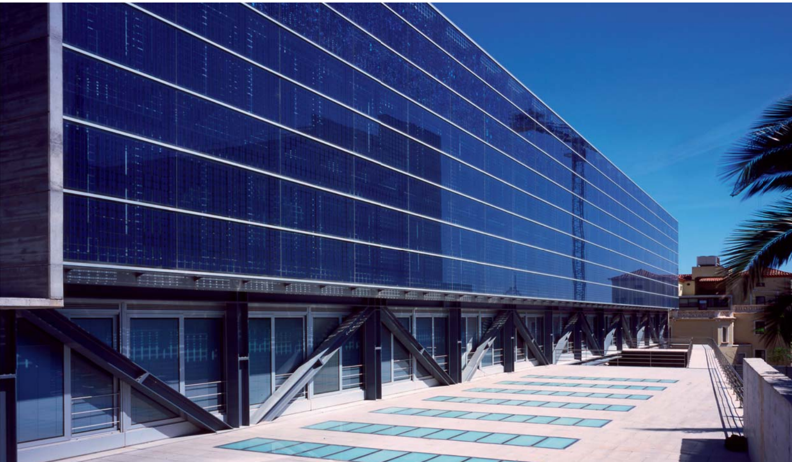
La Salle - Barcelona, Spanien (Architekt : Robert y Esteve Terradas Muntaniola)
